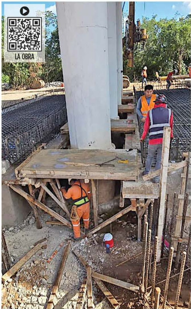
Trabajos de apuntalamiento intentan frenar el hundimiento de pilotes del Tren Maya.
